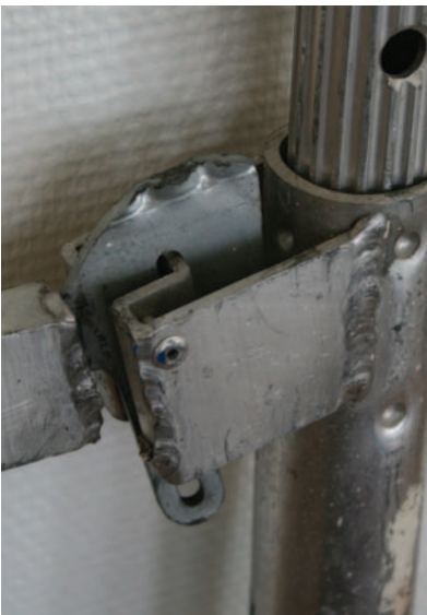
▶ Ett exempel på sammanfogning och svetsning som inte uppfyller Layher standard.
